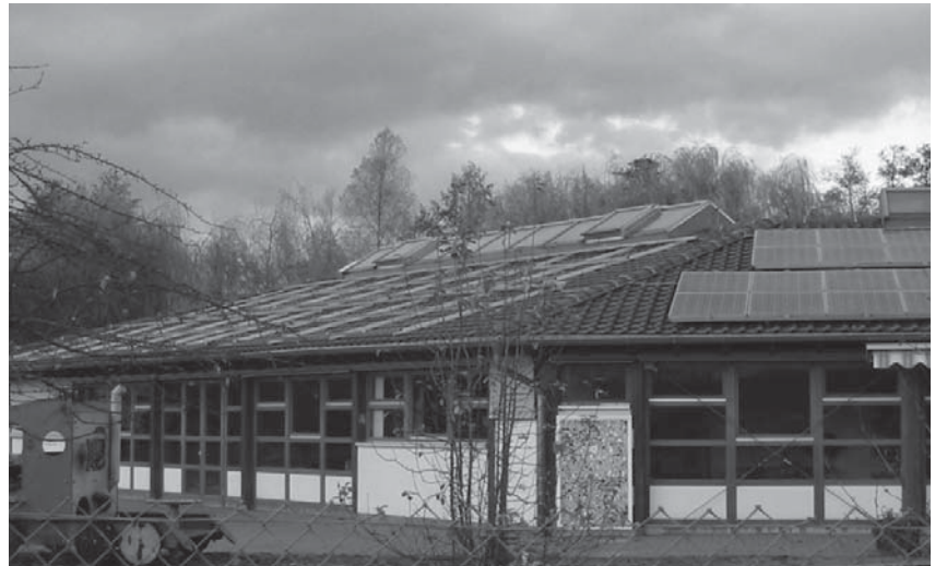
Kindergarten in Freiburg Hochdorf, November 2007: Diebstahl von 60 Solarmodulen von linker Dachseite Foto: Sonnenfänger Löwenzahn GbR
